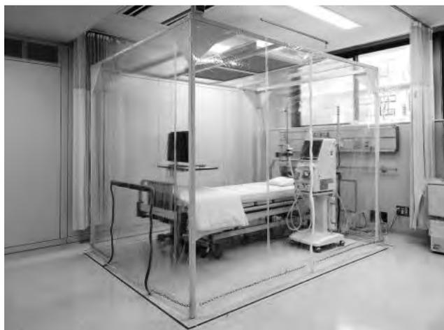
図4 透析隔離室 HEPAフィルター搭載陰圧クリーンブース
